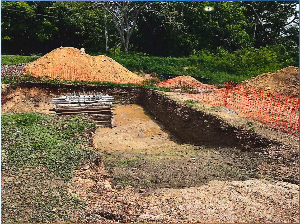
Imagen 2. Estructura en acero y hormigón donde se colocará la antena, material de la corteza terrestre depositado alrededor.
