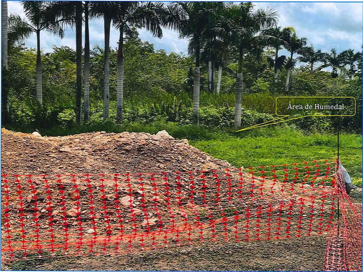
Imagen 5. Área de humedal a aproximadamente 30 pies metros de la construcción.
